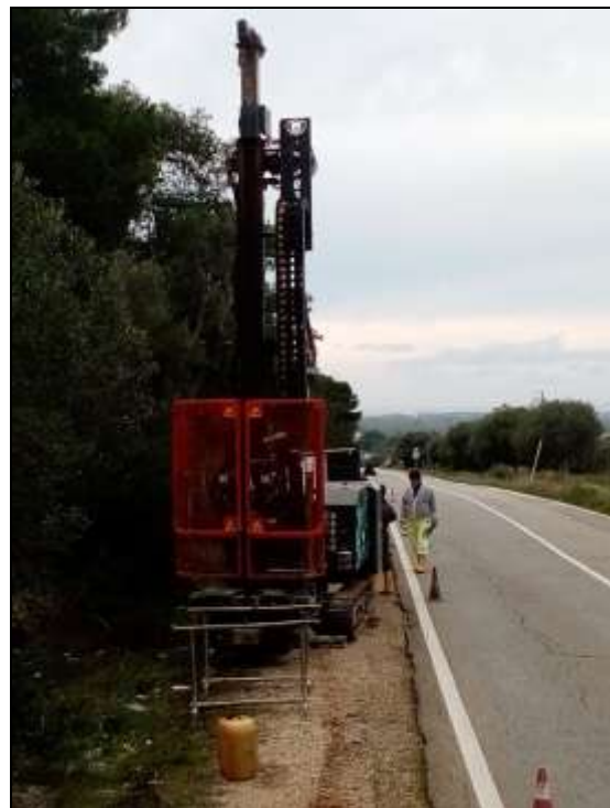
Figg. 6a e 6b – Messa in opera della macchina perforatrice per eseguire il sondaggio a carotaggio continuo.
